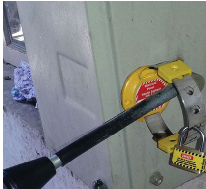
Barra eléctrica mantenida en la posición de apagado
